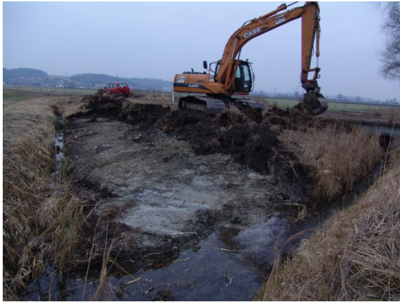
Abb. 10: Bau eines Absetzbeckens
