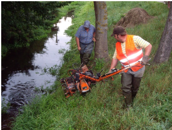
Abb. 5: Schonende Böschungsmahd mit handgeführtem Mähgerät mit Doppelmesserbalken
